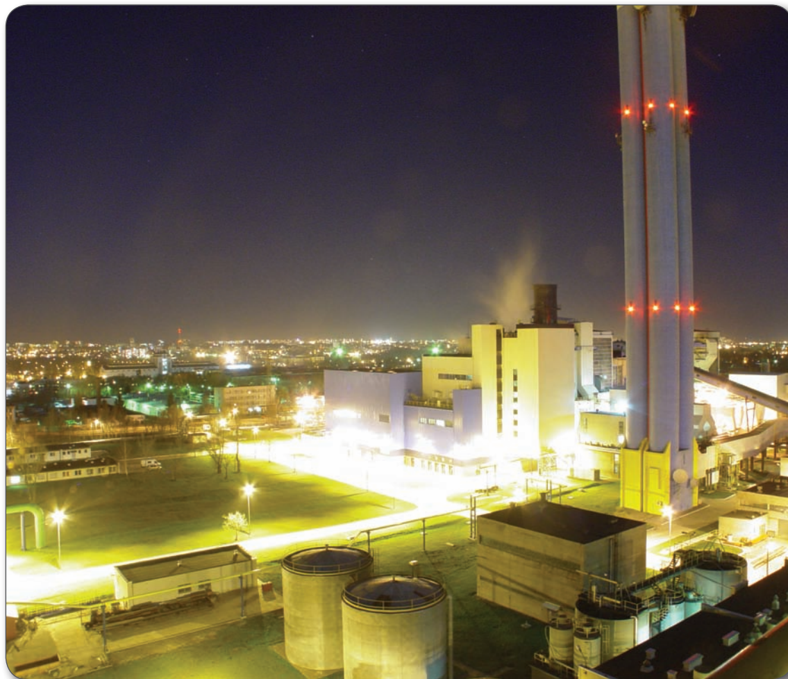
PGE GIEK SA Elektrociepłownia Lublin-Wrotków
